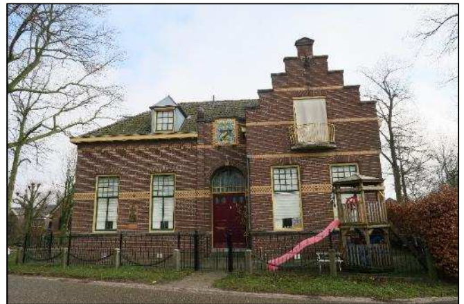
Foto 4. Voorgevel pand Dorpstraat
