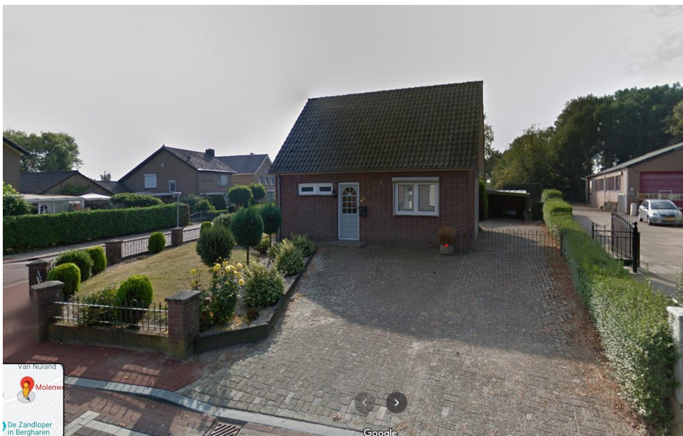
Afbeelding 2: Vooraanzicht onderzoekslocatie, vanuit Molenweg gezien (bron 4A)
