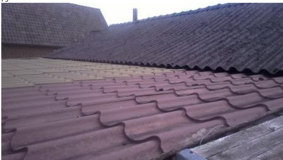
Asbesthoudend dak zonder dakgoot westelijk deel van de garage
