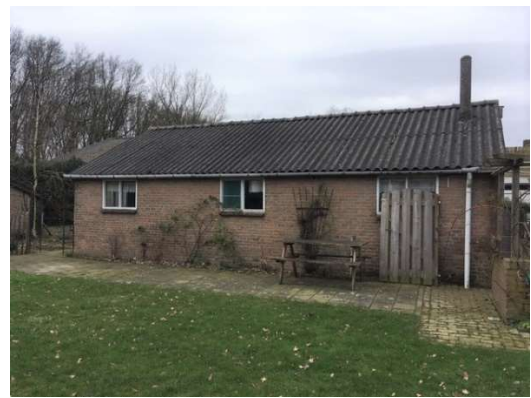
schuur op het erf
