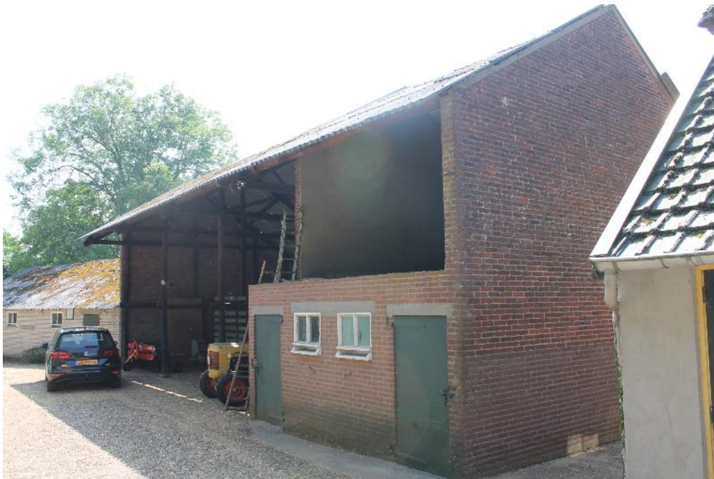
Figuur 1 De planlocatie is gelegen aan de Molenhoek 4 te Hernen en betreft een open kapschuur. De schuur wordt gesaneerd en bestaat uit gemetselde muren zonder isolatie en een zadeldak uit asbest golfplaten.
