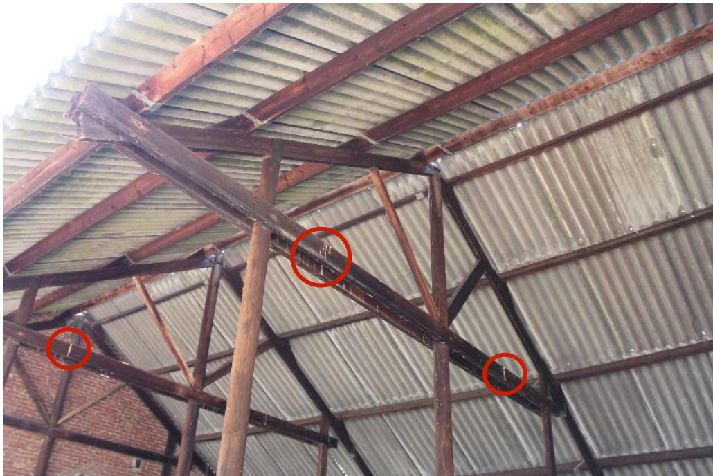
Figuur 2 De open kapschuur heeft geen dakbeschoot, waardoor er geen afgesloten ruimten zijn met geschikte nestlocatie voor vogels als huismus en gierzwaluw. Sporadisch zijn er krietstrepen aanwezig (rood omcirkeld), wat impliceert dat de kapschuur af en toe door vogels wordt gebruikt. Er zijn in de kapschuur geen sporen aangetroffen die duiden op een vaste nest- of verblijfplaats (bijvoorbeeld braakballen, prooiresten of geconcentreerde uitwerpselen) van uilen.
