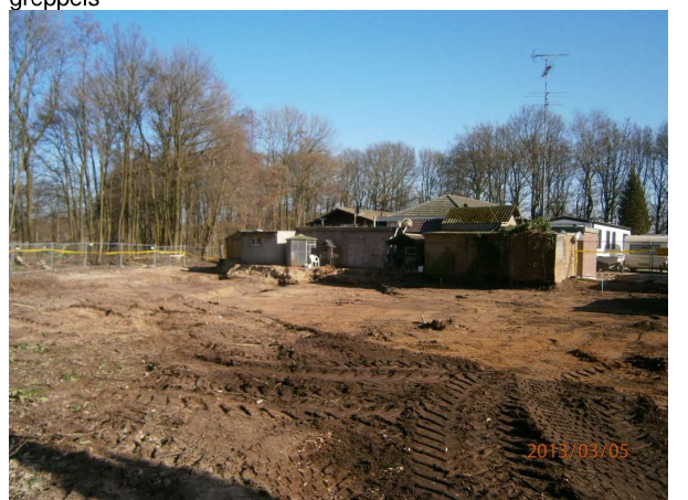
foto 8: 05-03-2013 saneringswerkzaamheden, opgeschoond terrein
