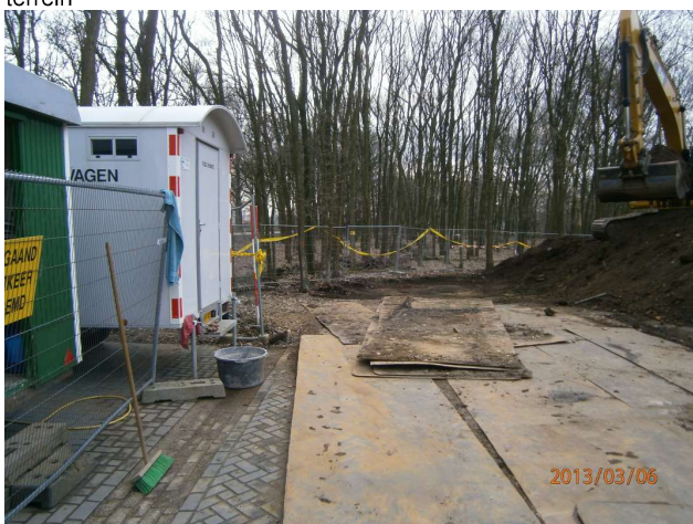
foto 11 : 06-03-2013 saneringswerkzaamheden, deco- en schafteet, rijplaten en tijdelijk depot
