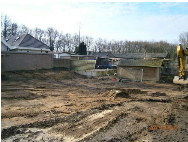
foto 9: 06-03-2013 saneringswerkzaamheden, opgeschoond terrein
