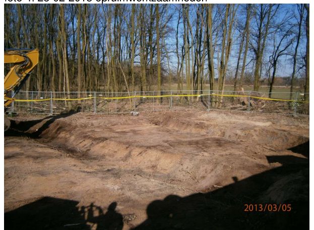
foto 6: 05-03-2013 saneringswerkzaamheden, opgeschoonde greppels
