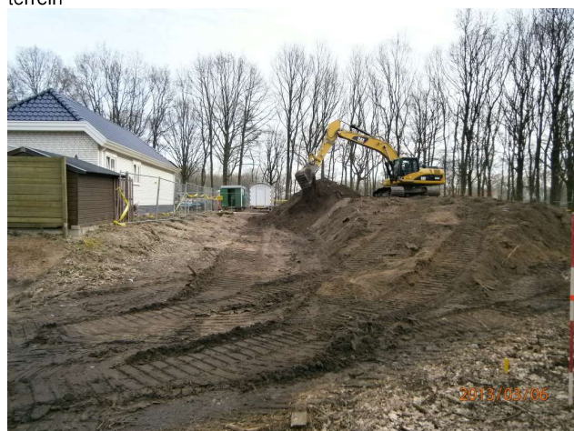
foto 12: 06-03-2013 saneringswerkzaamheden, deco- en schafteet en tijdelijk depot
