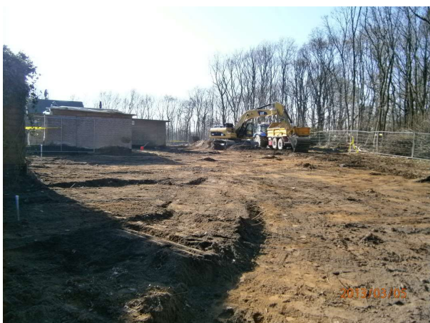
foto 7: 05-03-2013 saneringswerkzaamheden, opgeschoond terrein
