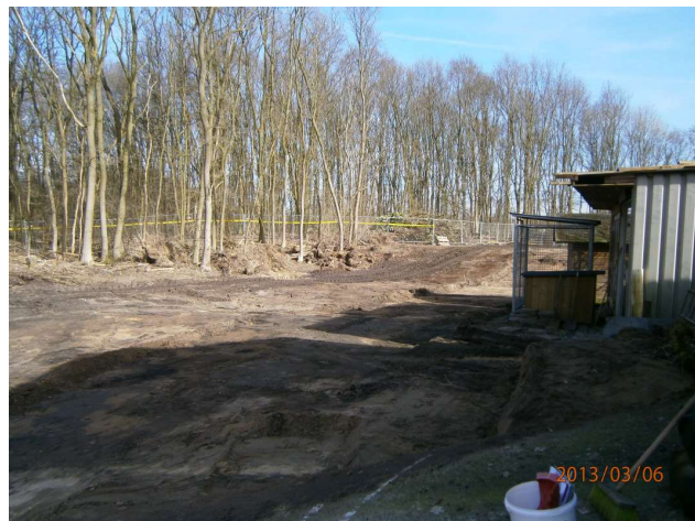
foto 10: 06-03-2013 saneringswerkzaamheden, opgeschoond terrein
