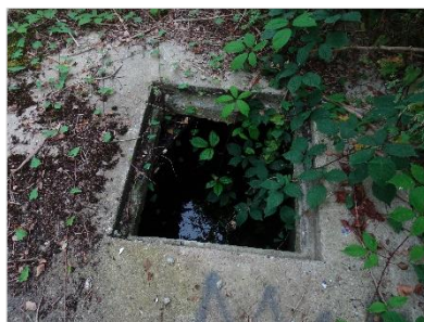
Figuur 4.2 Opening in fundering die toegang tot de kruipruimte biedt..
