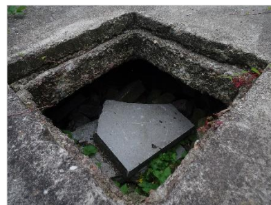
Figuur 4.3 Opening in fundering die toegang tot de kruipruimte biedt..
