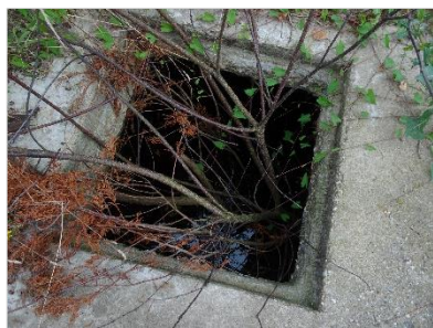
Figuur 4.1 Opening in fundering die toegang tot de kruipruimte biedt..
