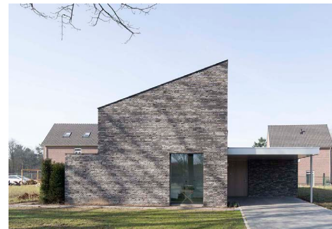
Lessenaarsdak gecombineerd met plat dak
