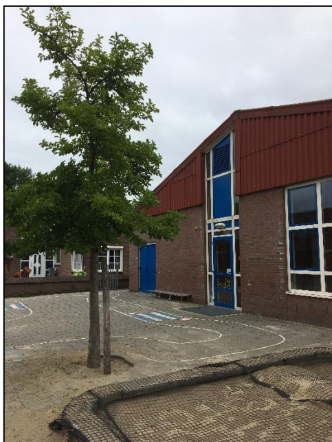
Foto 3. Westzijde van het schoolgebouw
