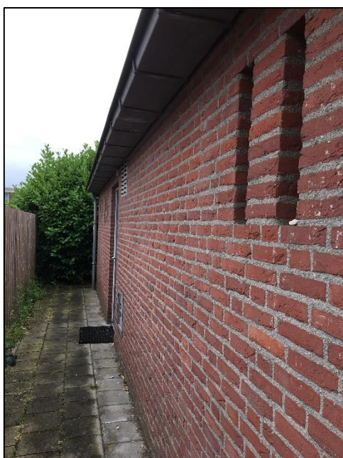
Foto 5. Noordzijde van het schoolgebouw
