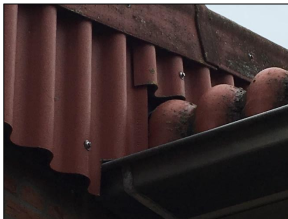
Foto 10. Muur/dakrand van het schoolgebouw
