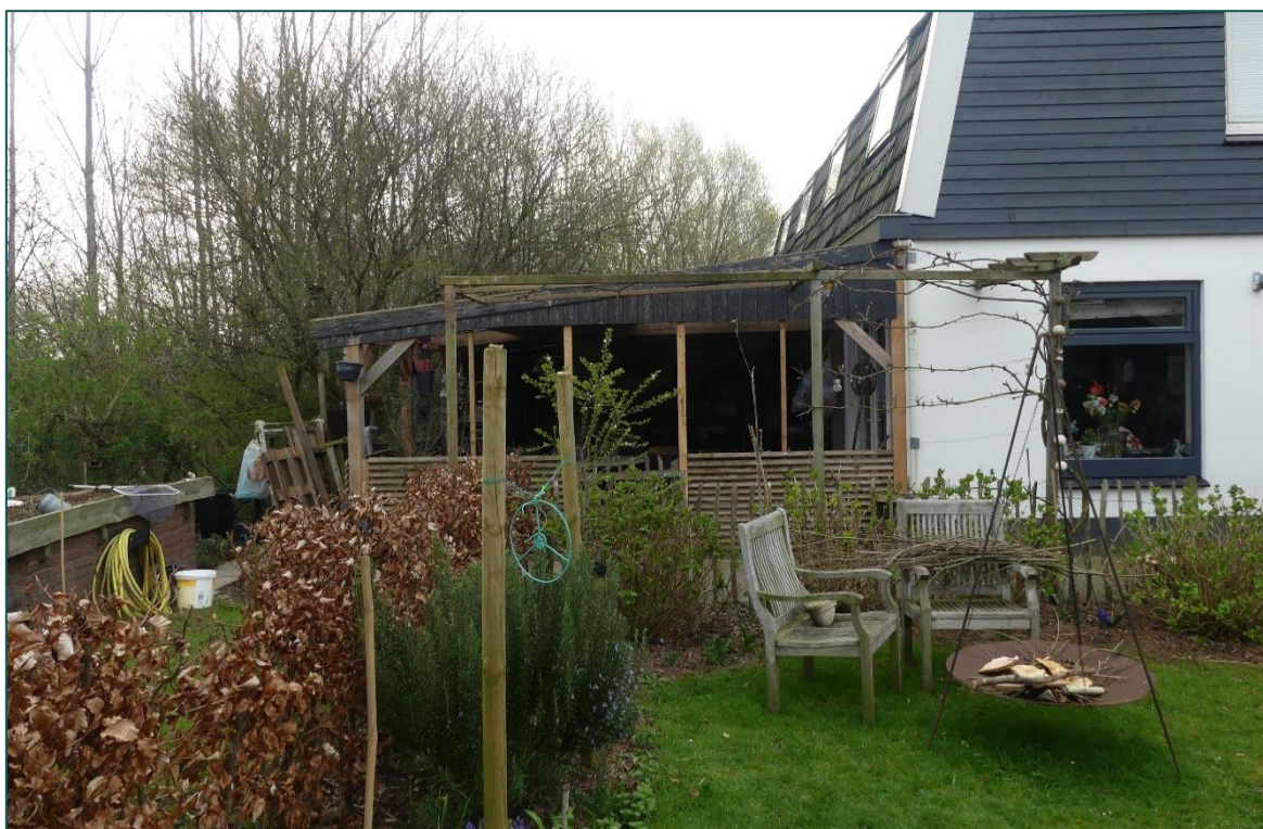
Figuur 2 De bebouwing bestaat uit een woning, overkapping en schuren.
