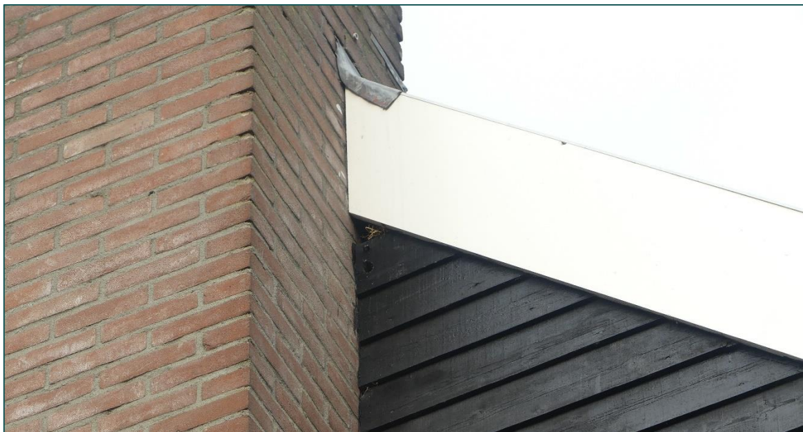
Afbeelding 3.3 Nestlocatie huismus in de dakpunt.
