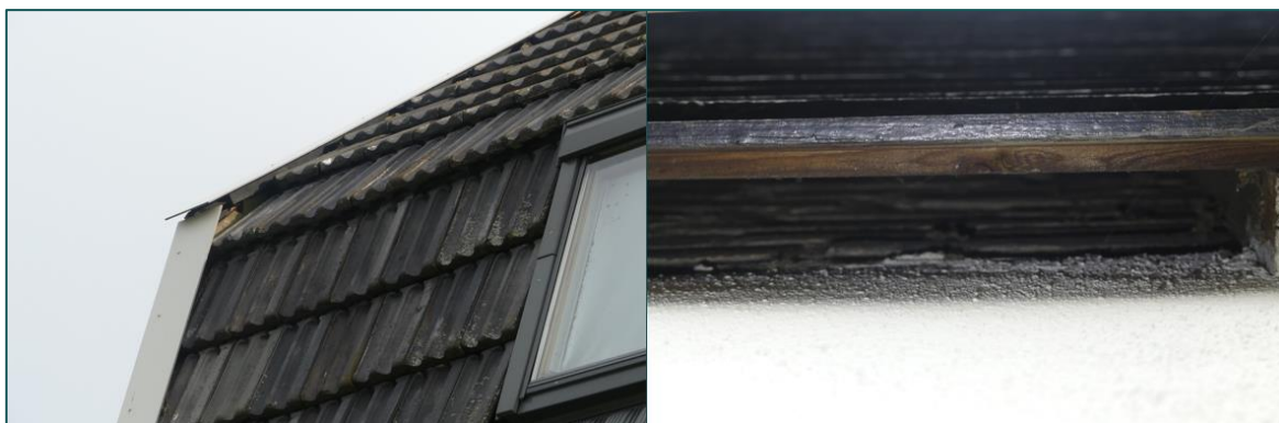
Afbeelding 3.1 en 3.2 Ruimte aanwezig tussen de dakpannen en ruimte aanwezig tussen de houten panelen en de buitenmuur
