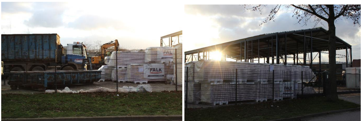
bedrijfspand met bedrijfsmaterieel en bouwmaterieel tbv het in aanbouw zijnde bedrijfspand
