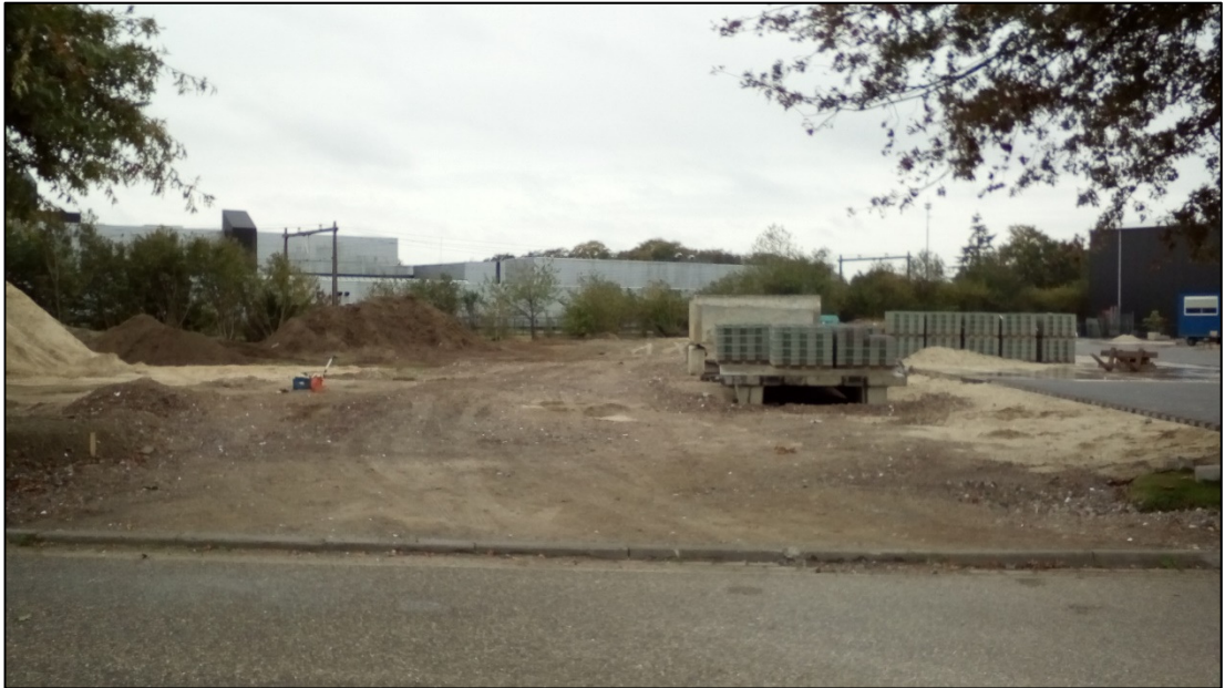
Afbeelding 16: Overzicht van het centrale en oostelijke deel van het plangebied. Foto genomen vanaf de Celsiusstraat
