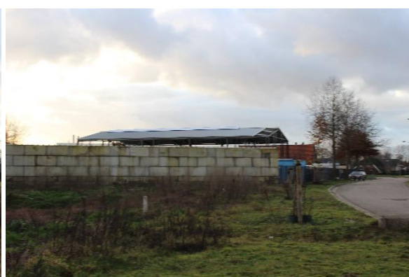
keerwand van legioblokken
