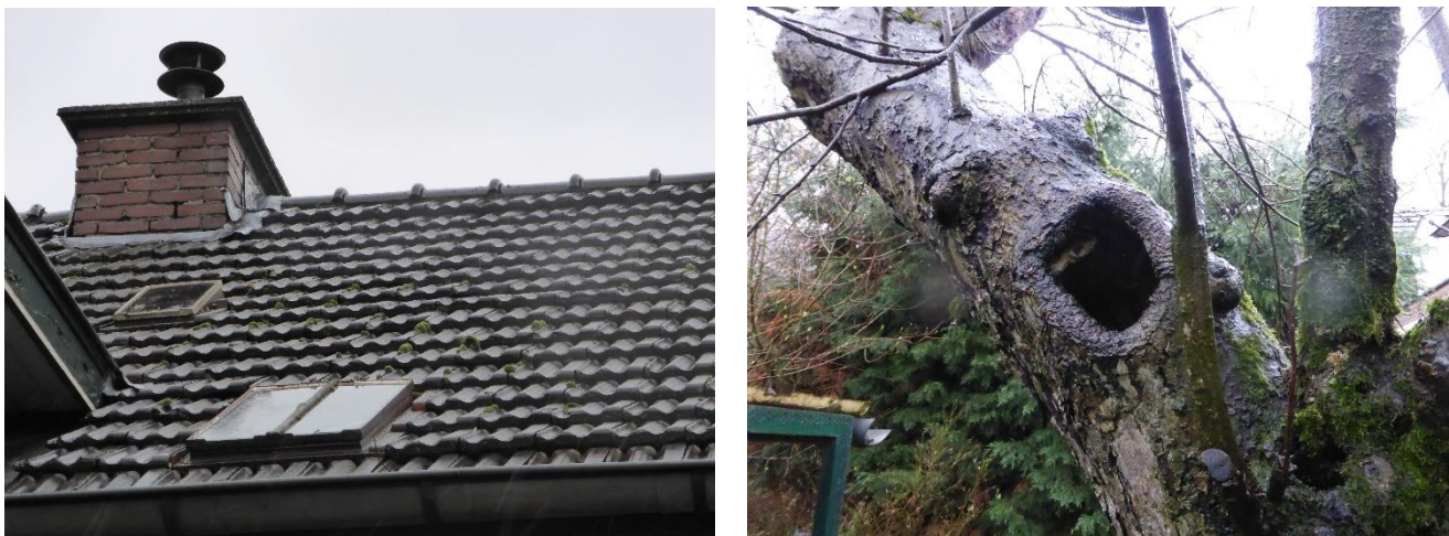
Afbeelding 5: naast de ruimtes bij de dakpannen (afbeelding 4 zijn in de gebouwen binnen het plangebied zijn ook andere geschikte invliegopeningen aanwezig die vleermuizen gebruiken zoals ruimtes achter de betimmering/dakgoot, loodslabben en holtes in de bomen.
