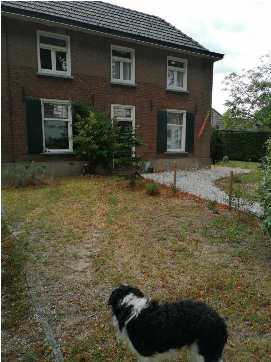
Afbeelding 16: Impressie van de voorzijde van Kasteellaan 48/50 (locatie boring 6)
