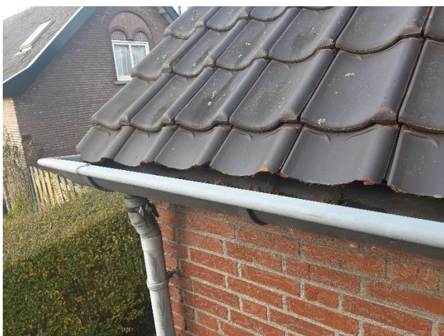
Afbeelding 6. dakrand vrijstaande woning
