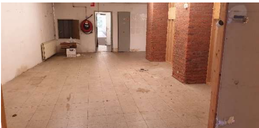
Binnenzijde winkelpand Spoorstraat 53
