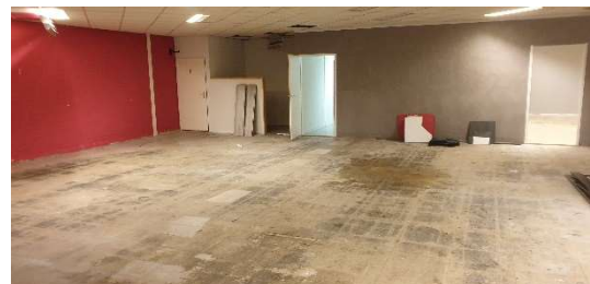
Binnenzijde winkelpand Herenstraat 36
