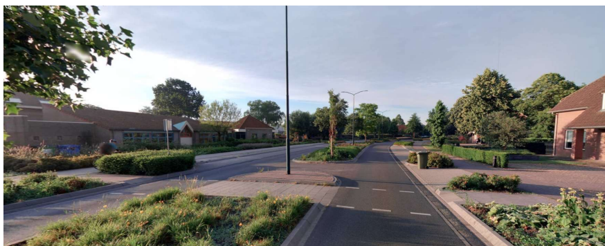
Voetgangersoversteekplaats met kanalisatiestrepen
