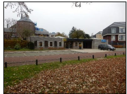
Figuur 5. Uitvaartverzorgingscentrum Jan Wessels in deelgebied A.
