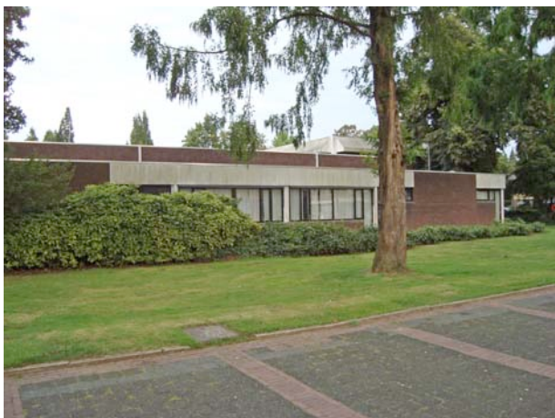
Foto 1. Westzijde plangebied met te slopen gebouw.
