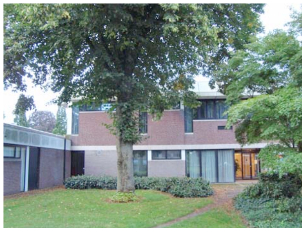
Foto 2. Zuidzijde plangebied met te slopen gebouw (links) en te behouden gebouw (rechts).
