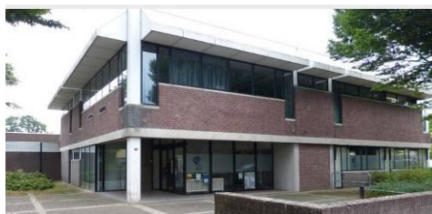
Figuur 5 Voorzijde bestaand gebouw
