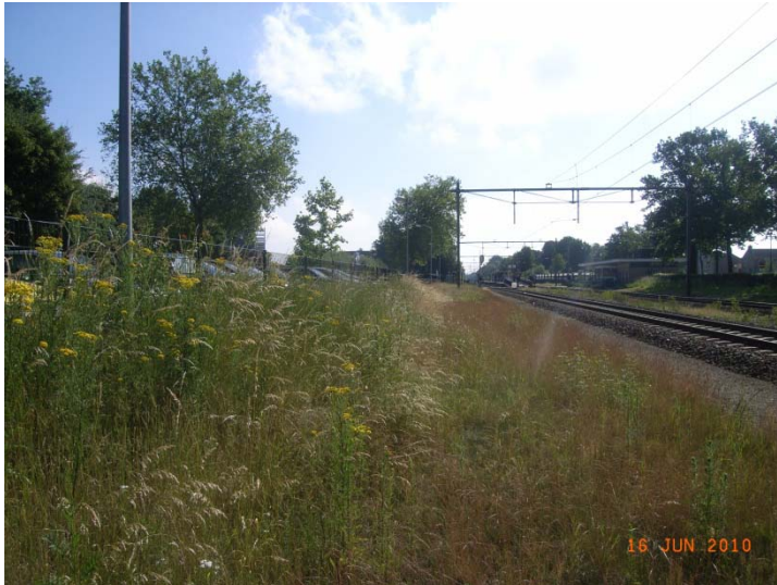
Figuur 3: spoorberm tussen km 56.14 (Tunnelweg) en 56.3
