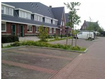
Parkeren gescheiden van rijbaan door molgoot
