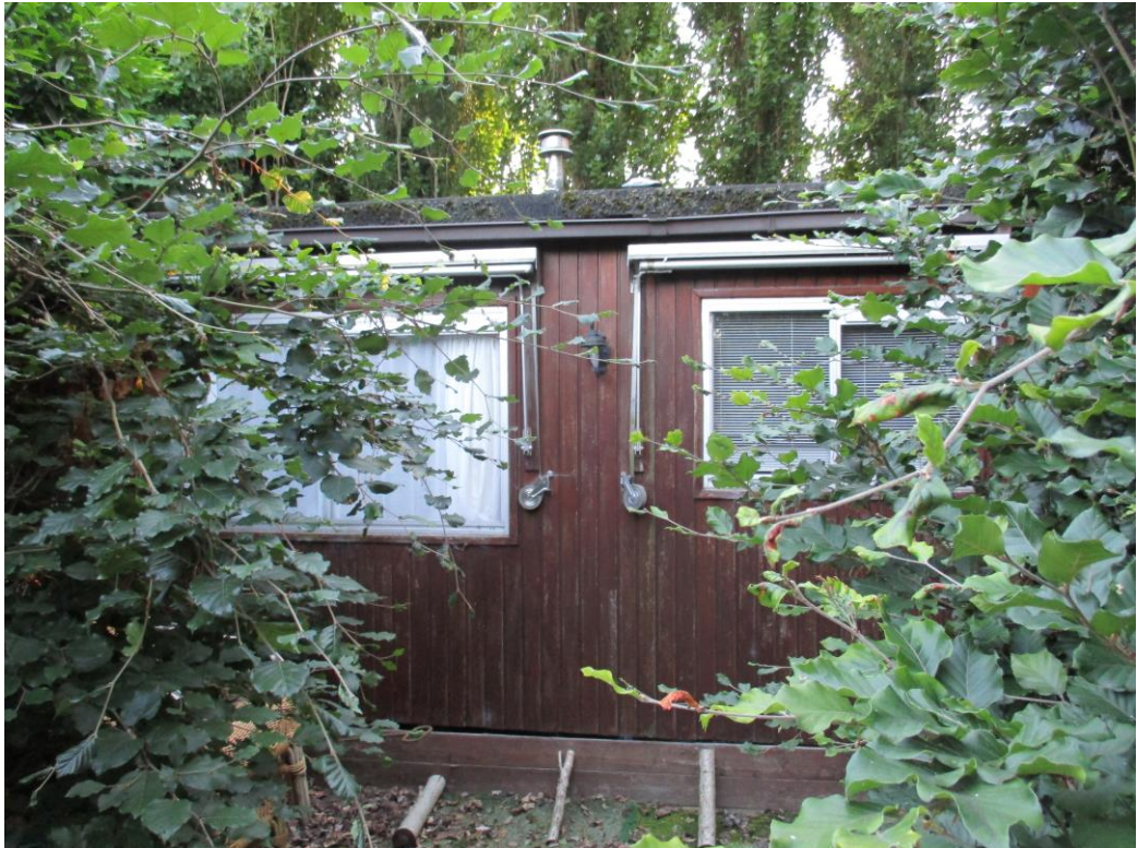
Figuur 3 De unit is opgetrokken uit houten planken en een plat bitumen dak.
