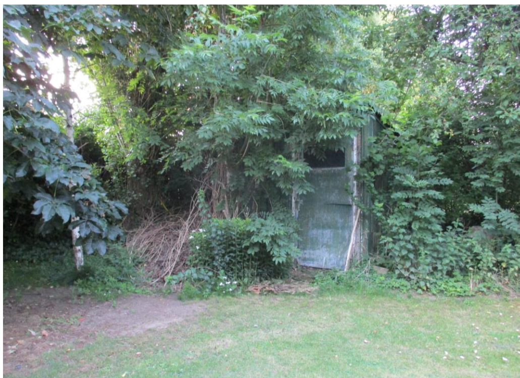
Figuur 2 Het kleine schuurtje is opgetrokken uit houten platen, houten planken en een golfplaten dak.
