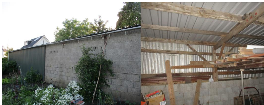
Figuur 3 In de grote schuur/ garage, welke is opgetrokken uit betonnen blokken en metalen damwandplaten, zijn geen openingen aanwezig welke vleermuizen toegang kunnen verlenen tot de bebouwing. Tevens is er geen spouwmuur, dakbeschot, of andere geschikte opening aanwezig, en kunnen in de bebouwing derhalve geen verblijfplaatsen aanwezig zijn.
