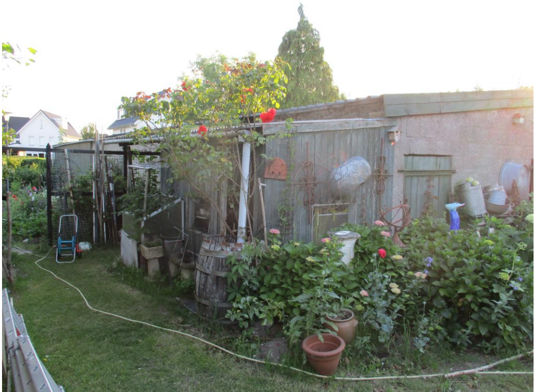
Figuur 4 De grotere schuur is opgetrokken uit betonnen blokken en metalen damwandplaten. Aan de zuidoostelijke zijde is een kleine houten overkapping tegen de schuur bevestigd.
