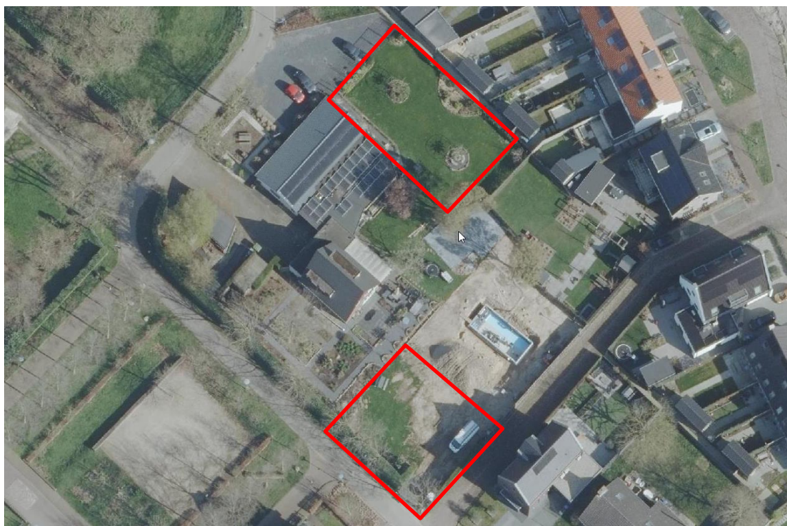
Figuur 4: luchtfoto van de onderzoekslocatie.
