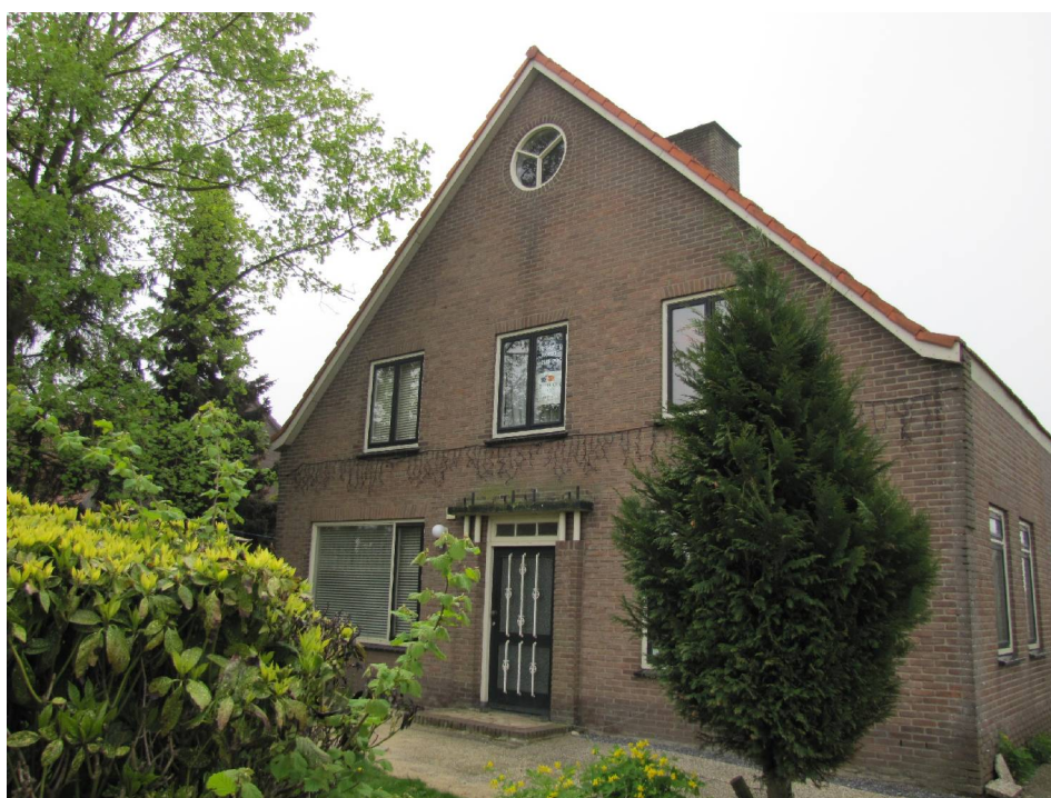
Figuur 5. Voorgevel van de boerderij.
