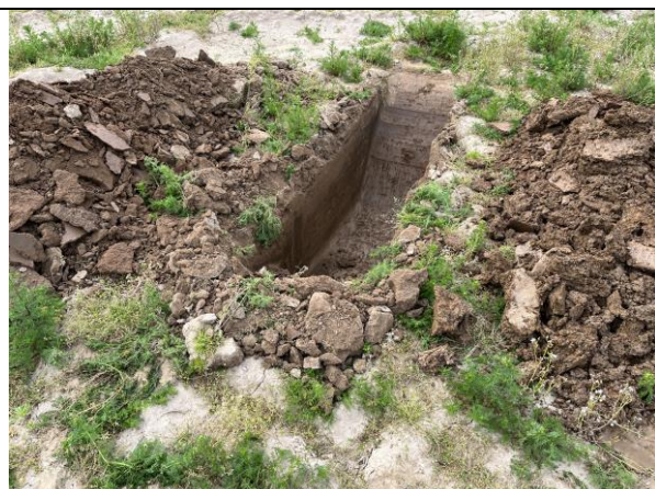
Proefsleuven nader onderzoek naar asbest
