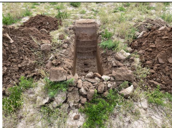
Proefsleuven nader onderzoek naar asbest
