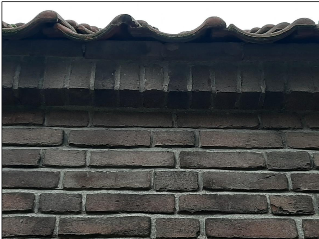
Figuur 4 De onderste rij dakpannen van de schuur is niet toegankelijk voor huismussen door de te beperkte grootte van de openingen en de afwezigheid van een dakgoot.
