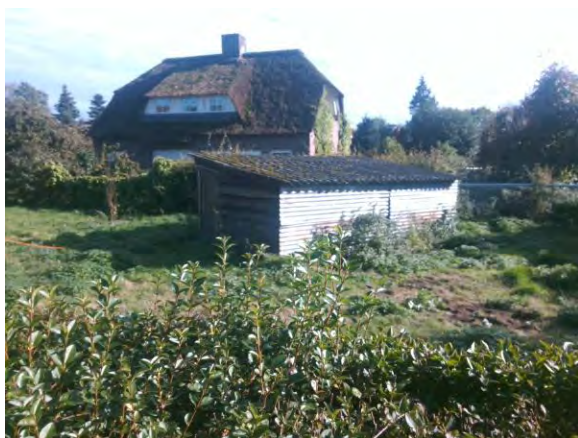
Figuur 8: Asbestverdachte bebouwing
