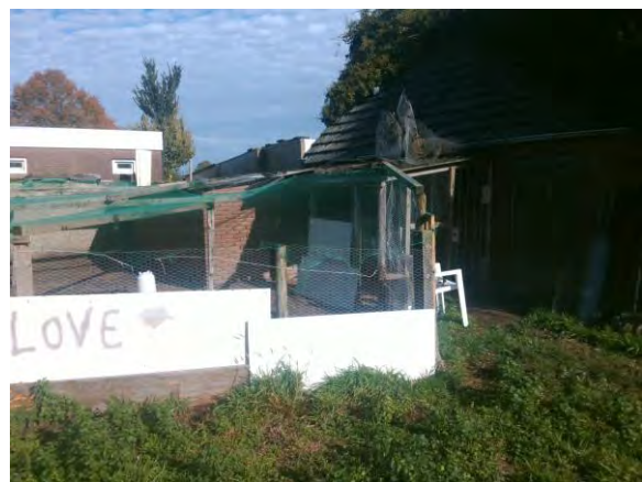
Figuur 9: Asbestverdachte bebouwing
