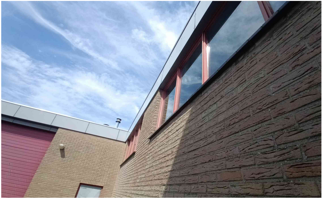
Figuur 5.10. Geen openingen en spleten Kraanvogelstraat 9
