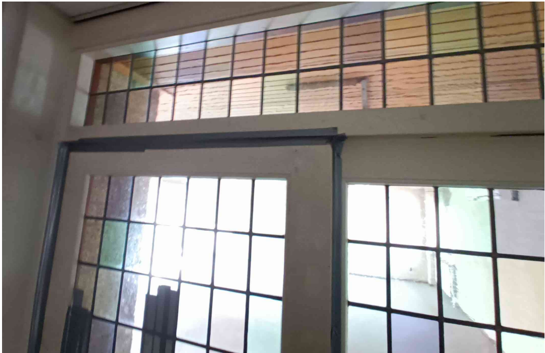
Figuur 5.7. Afgeplakte deur en glasopeningen
