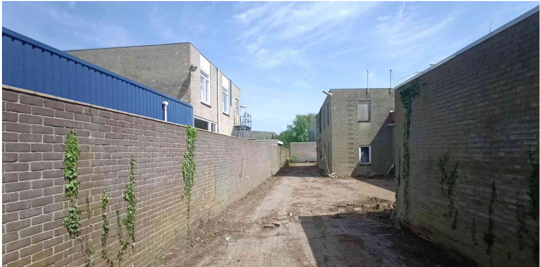
Figuur 5.1. Beperkte begroeiing muren en gevels achterzijde Kraanvogelstraat 15 en 15 a
