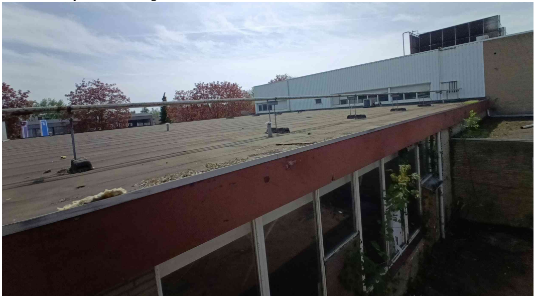
Figuur 5.3. Bestaand dak Kraanvogelstraat 15 en 15 a
