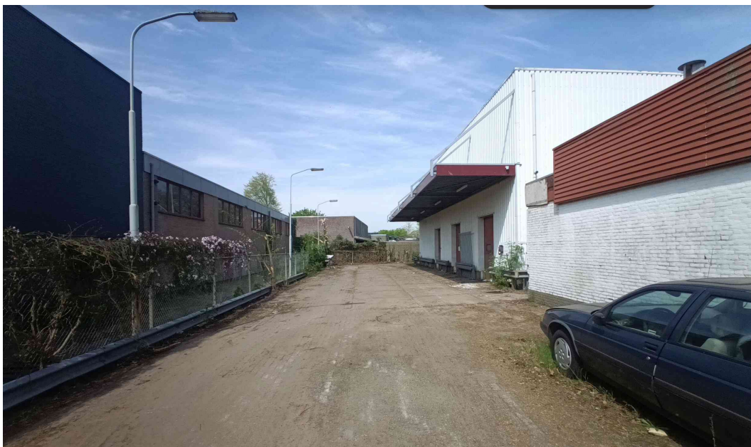
Figuur 3.7. Verharding, lichtmasten en gevels tussenzone Kraanvogelstraat 9 en 15
