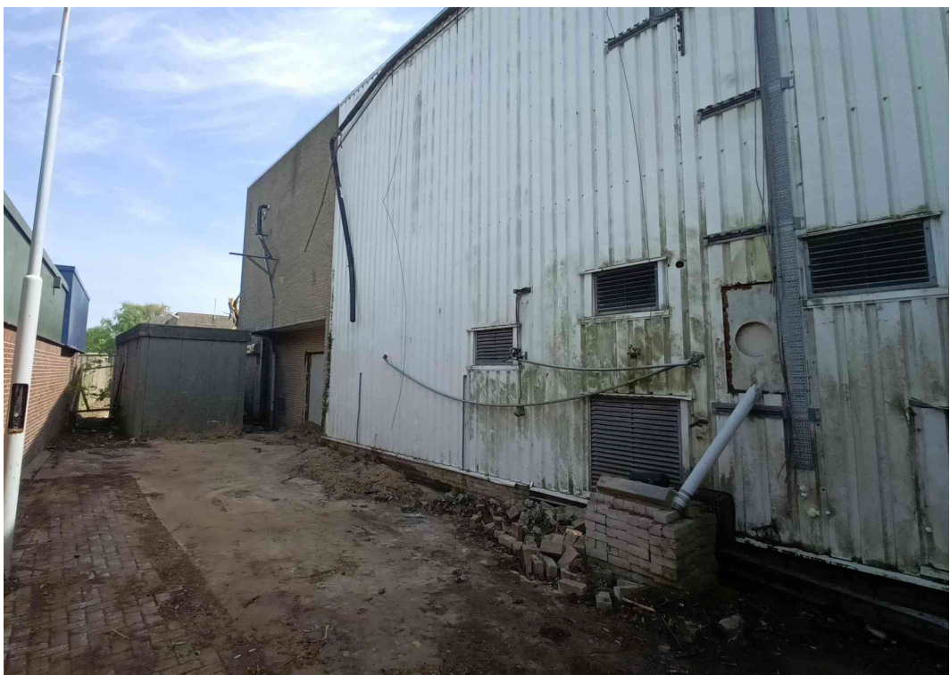
Figuur 3.6. Verharding, lichtmast en gevels achterzijde Kraanvogelstraat 15 en 15 a
