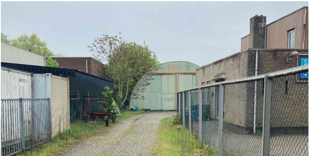
Figuur 5.2. Opschot en begroeiing op verharding achterzijde Kraanvogelstraat 7
