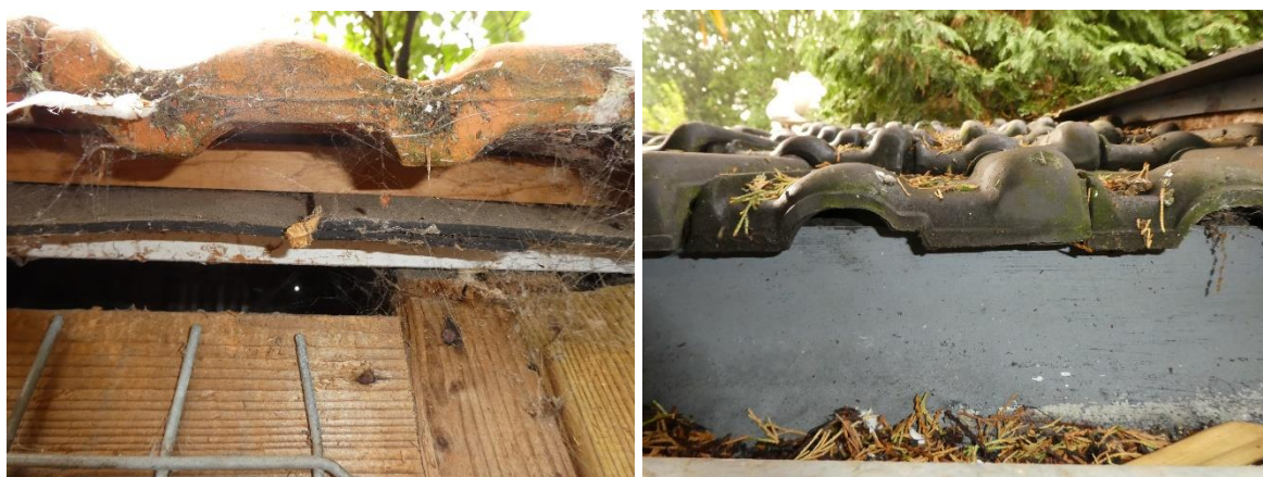
Afbeelding 7 en 8: geen mogelijke nestlocaties van de huismus in de te slopen bijgebouwen. Bron: BNL advies, datum: 07-09-2022
