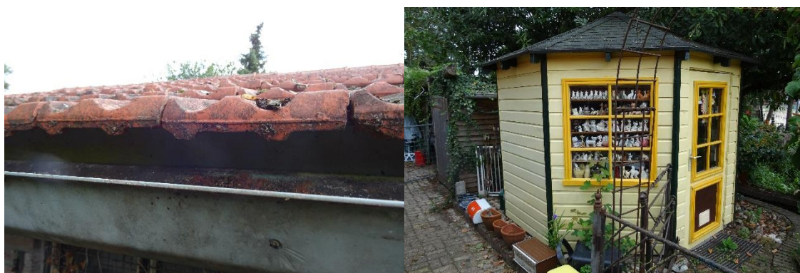
Afbeelding 7 en 8: Dak van het bijgebouw met dakpannen en het dak van het tuinhuis belegd met singels. In beide bijgebouwen zijn door de gebruikte materialen / de vorm er van, geen geschikte ruimtes aangetroffen voor huismussen om te verblijven/ voort te planten. Datum: 24-08-2020
