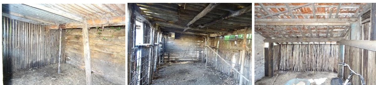
Afbeelding 9 t/m 11: te slopen bebouwingen zonder dakbeschot, spleten en kieren waar huismussen tussen kunnen nestelen. Bron: BNL advies, datum: 07-02-2022
