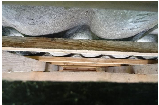
Afbeelding 2 en 3: Dak voorzien van dakpannen op panlatten, zonder dakbeschot. Bron: Rik Bijvelds, 12-03-2020
