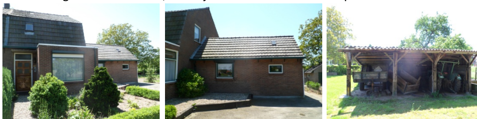
Foto's: Het te verbouwen voorhuis en de te slopen aanbouwen en schuur.
