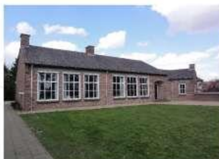
Kerkstraat 9: schoolgebouw, bouwjaar ca. 1950 (foto: Havang)
