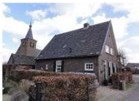
Kerkstraat 7: woning, bouwjaar 1925 (foto: Havang)
