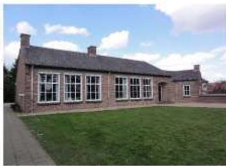
Kerkstraat 9: schoolgebouw, bouwjaar ca. 1950 (foto: Havang)
