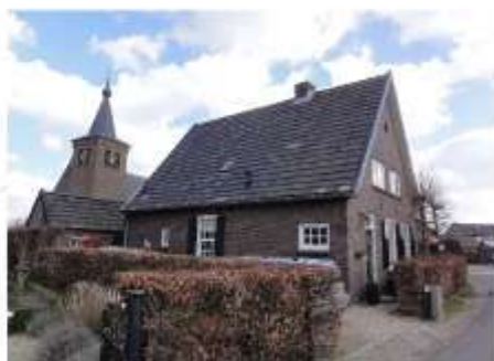
Kerkstraat 7: woning, bouwjaar 1925 (foto: Havang)
