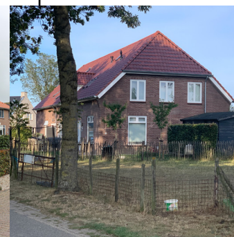
Bestaande voormalige boerderij
