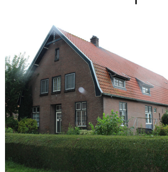
Bestaande voormalige boerderij
