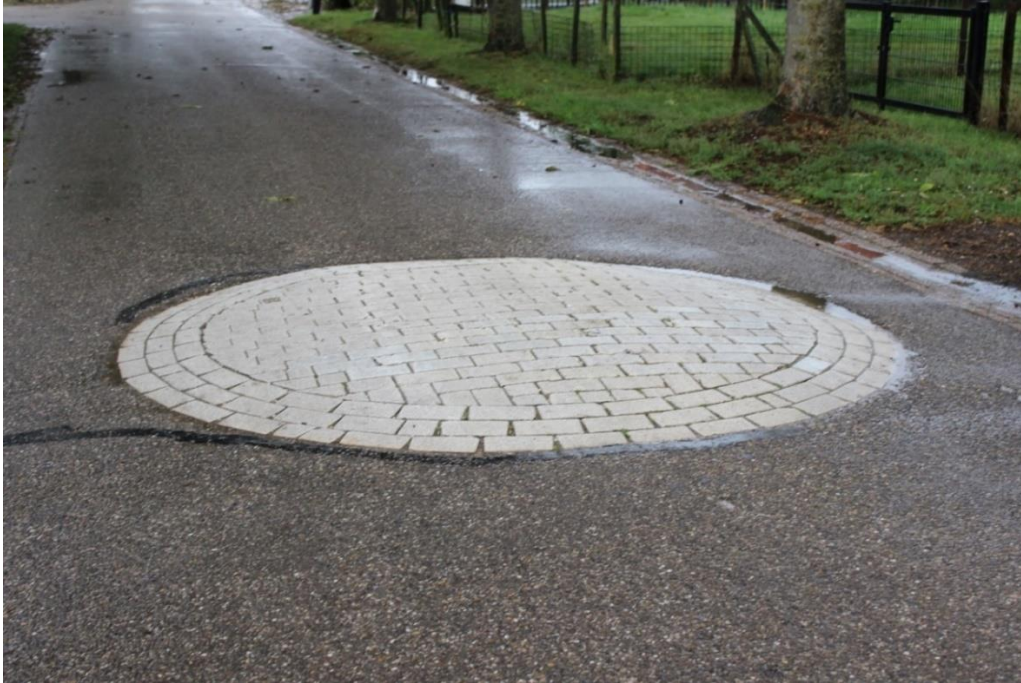
punaise in het wegdek ter plaatse van het plangebied aan de Dorpsstraat
