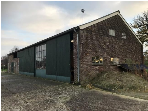
de te slopen agrarische schuren op het erf
