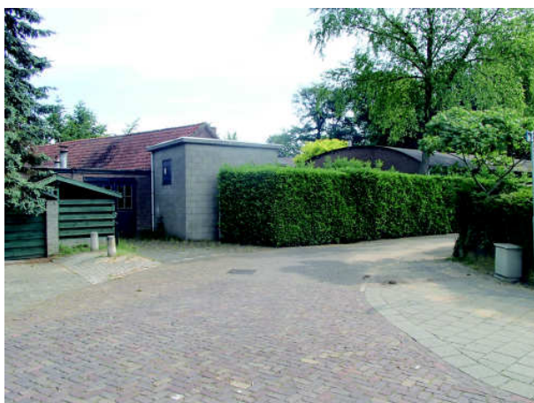
achterzijde aan Grootvenseweg met transformatorhuisje
