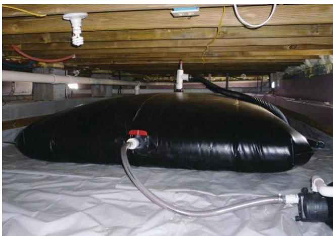
Afbeelding 12: Voorbeeld toe te passen waterzakken in kruipruimte.
