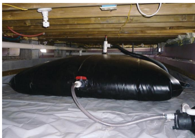
Afbeelding 12: Voorbeeld toe te passen waterzakken in kruipruimte.
