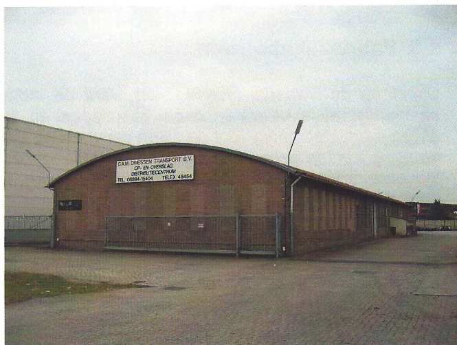
Industrieterrein Nieuweweg te Wijchen: bedrijfshal gebouwd met gebruikmaking van het Romneysysteem (links) en een bedrijfshal met schaaldak (rechts).
