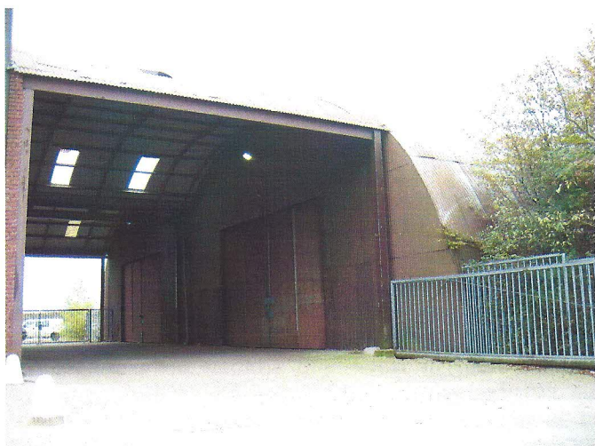
Industrieterrein Nieuweweg te Wijchen: bedrijfshal gebouwd met gebruikmaking van het Romneysysteem (links) en een bedrijfshal met schaaldak (rechts).
