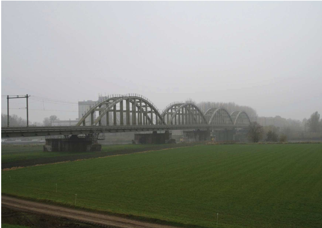
Figuur 16. De (na de oorlog herbouwde) spoorbrug bij Ravenstein.
