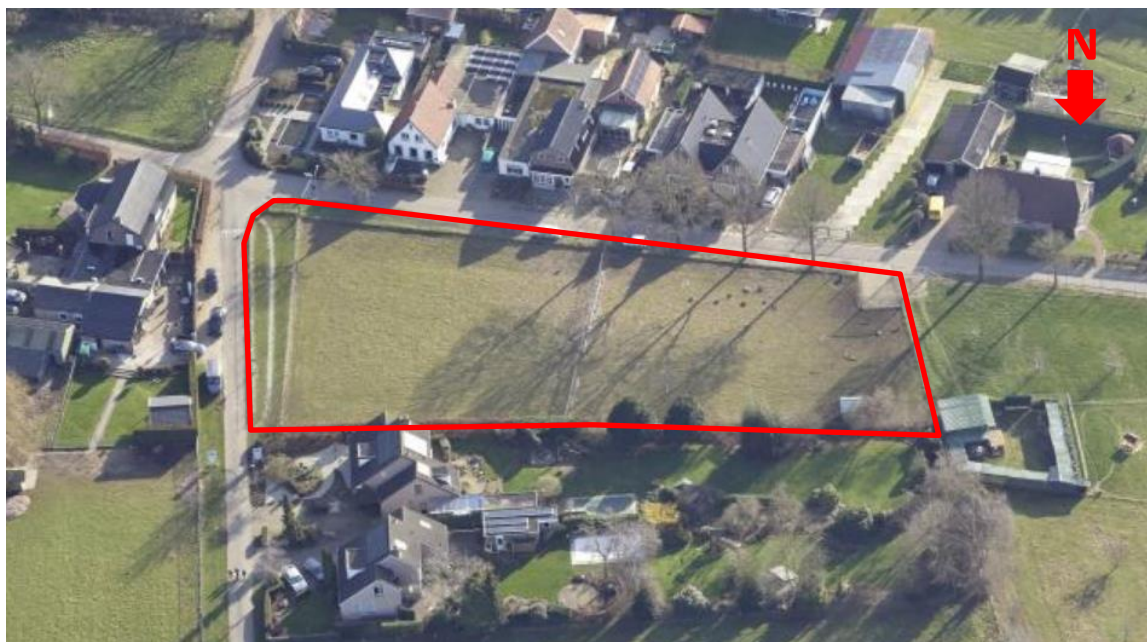
Figuur 4: luchtfoto van de onderzoekslocatie.
