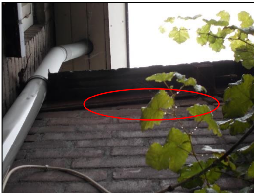
Foto 1. Ruimte onder gevelbetimmering.
