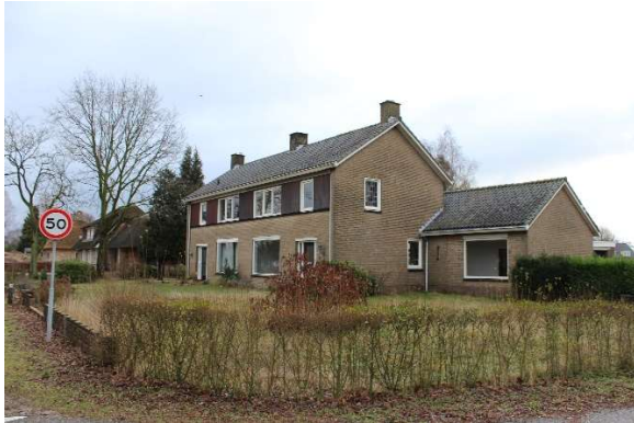
foto van het bestaande dubbele woonhuis
