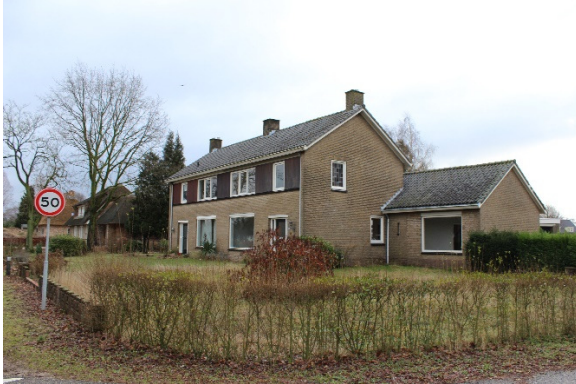
foto van het bestaande dubbele woonhuis
