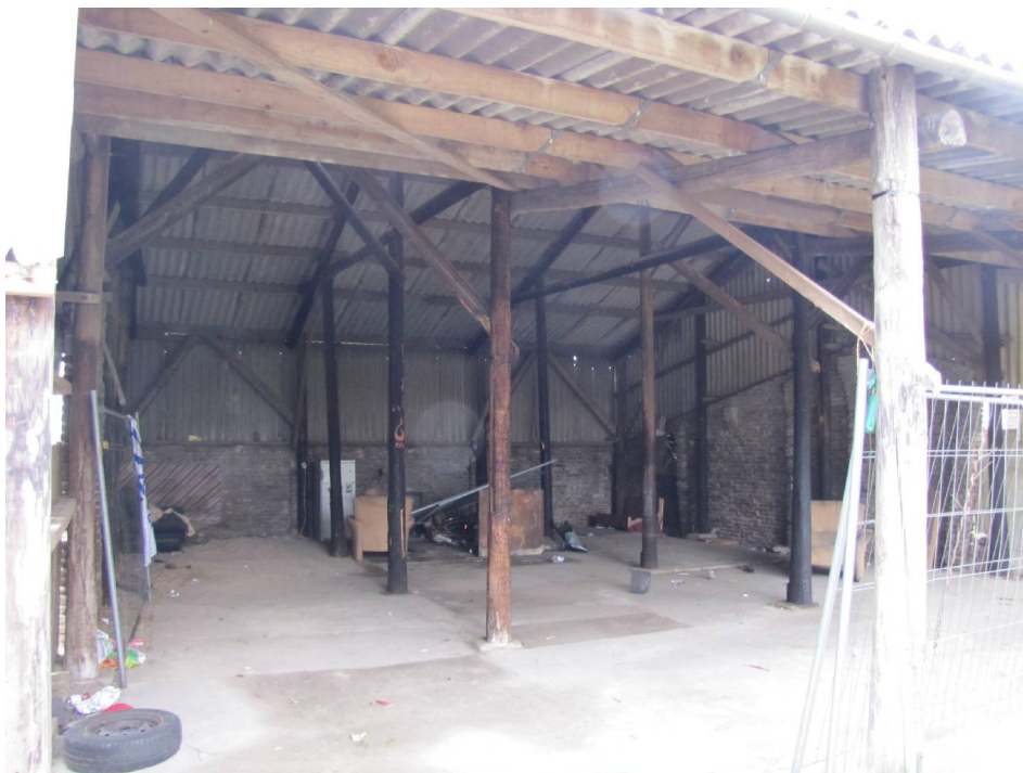
Figuur 5. Open kapschuur.
