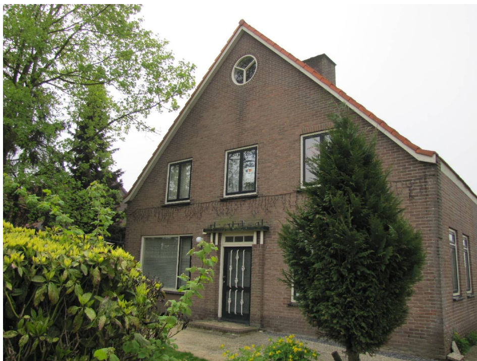
Figuur 5. Voorgevel van de boerderij.
