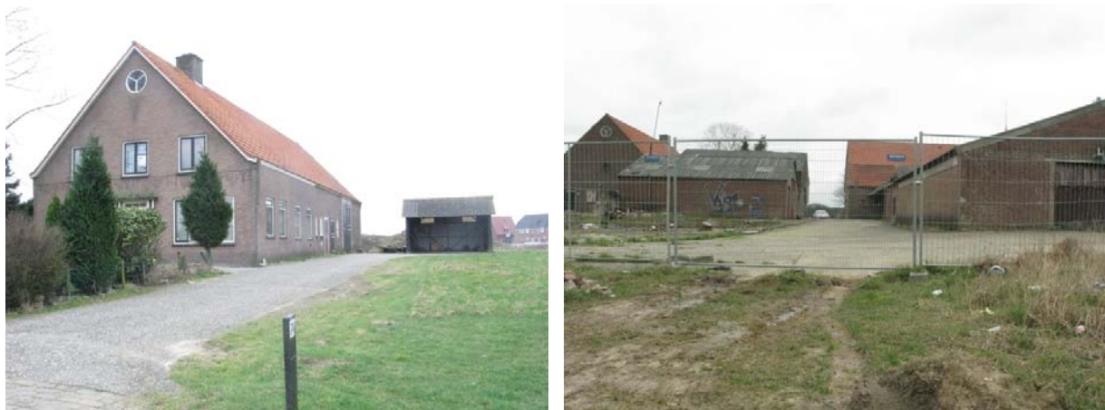
Afbeelding 10: links de bebouwing aan de Huurlingsedam 74, rechts de te slopen bebouwing op het perceel Huurlingsedam 78
