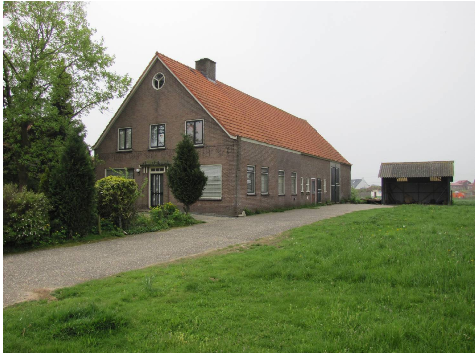
Figuur 2. Overzicht plangebied met de te slopen opstallen en een deel van de tuin.
